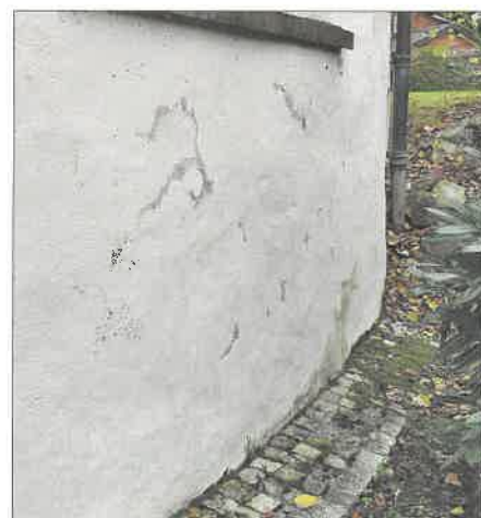
Die Kirchentreppe ist aus Sandstein und hat über die Jahre durch Feuchtigkeit und Benützung gelitten. Die Orgel erhält den grossen Service. Und die Schäden an der Kirchenwand zeigen, dass die Sickerleitungen die Feuchtigkeit nicht mehr abtransportieren.
