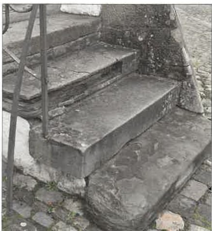
Die Kirchentreppe ist aus Sandstein und hat über die Jahre durch Feuchtigkeit und Benützung gelitten. Die Orgel erhält den grossen Service. Und die Schäden an der Kirchenwand zeigen, dass die Sickerleitungen die Feuchtigkeit nicht mehr abtransportieren.
