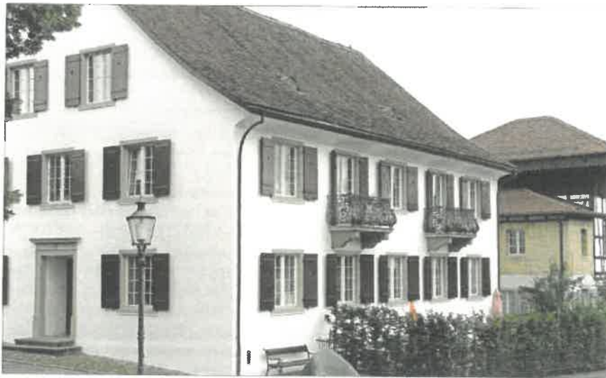
Das Alte Diakonenhaus erstrahlt im neuen Glanz und mit roten Fensterläden.
